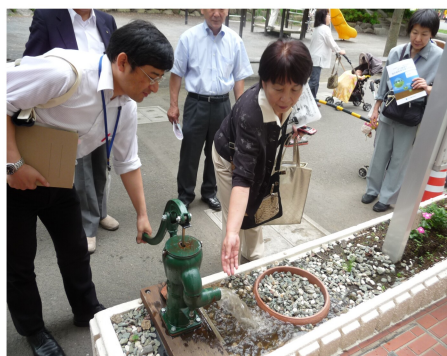
地中熱利用空調システムを視察
