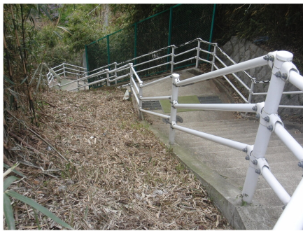
仮設子母口小への80段の階段
