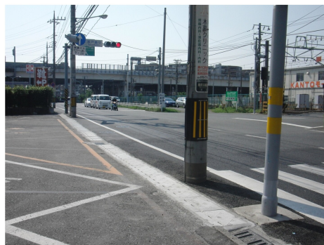
補修工事が完了した側溝
